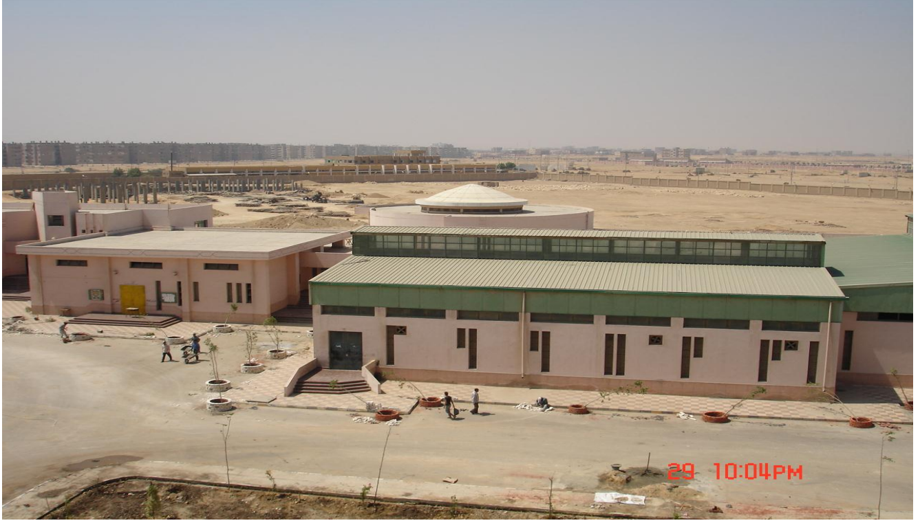
شكل رقم ٤: مدرج ومبنى الغزل والنسيج، مساحة المبنى ٤٠٠٠ متراً مربعاً.
