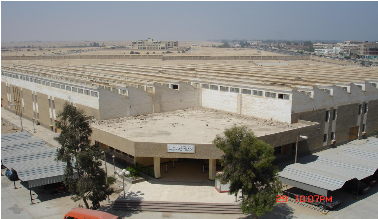
شكل رقم ٣: الورش التعليمية، مساحة المبنى ١٨٨٠ متراً
