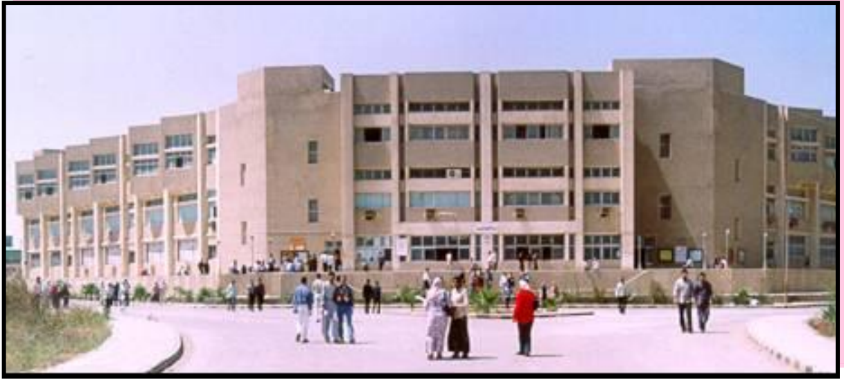
شكل رقم ٢: المبنى الإداري التعليمي القائم على مساحة ٢٧٧٠ متراً مربعاً بإرتفاع ثلاثة أدوار.
